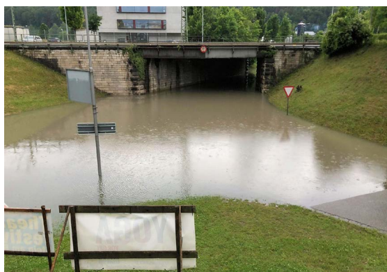
Die Unterführung Erlengasse steht nach den heftigen Niederschlägen vom 28. Juni unter Wasser.
